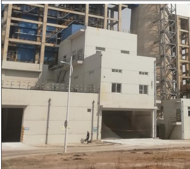
脱硫废水间+石膏库+电石渣库
