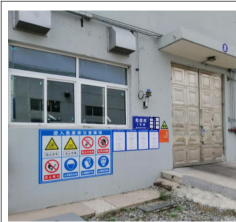
危废暂存库外部
